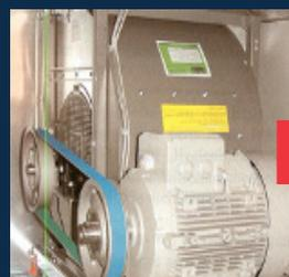
Ineffizienter riemengetriebener Ventilator
