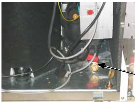
napúšťací a vypúšťací kohút v okruhu soľanky
