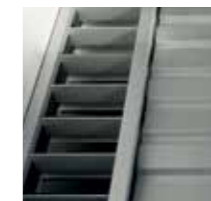
7 Klapky vyrobené z eloxovaného hliníka
