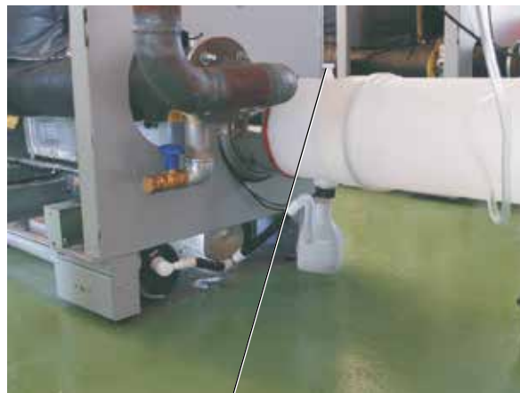
Otwór pomiarowy do analizy spalin
