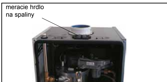
meranie spalín na kotle bez plášťa
