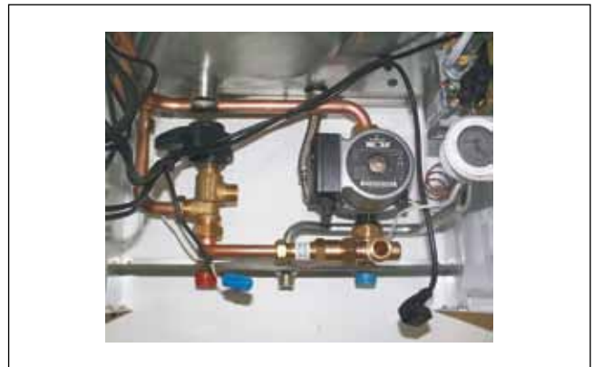
demontáž pripájacieho bloku
