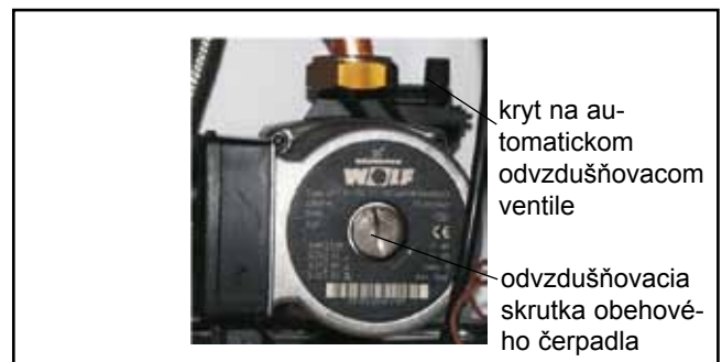
automatický odvzdušňovací ventil na obehovom čerpadle
