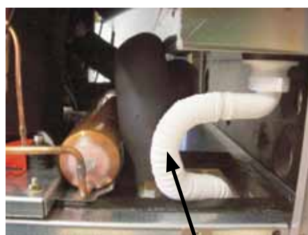
odvod kondenzátu so stálym spádom
