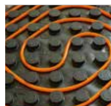
Podlahové vytápění/chlazení 1.2.3 Mokrý systém
