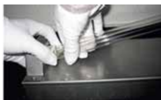
1. UVC-lichtbuizen in de fitting steken
