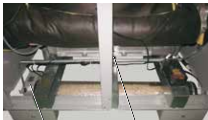
Instalación bomba elevadora de condensados
