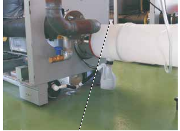
Toma de medición en el tubo adaptador para salida de gases de combustión con recogida de condensados
