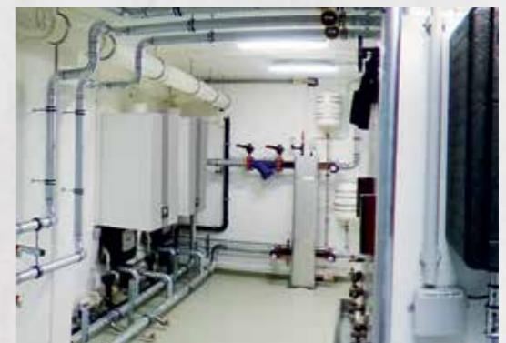
Až päť kotlov v kaskáde s výkonom do 500 kW riadenej modulom KM-2 ponúka široké možnosti využitia. K štandardnému vybaveniu kotlov patria spätné klapky vo vzduchospalinovej ceste pre spalinové kaskády. Zariadenie je možné navyše ľahko integrovať do riadiacich systémov budov, čo podčiarkuje ich flexibilitu. Možno ho tak ľahko využiť napríklad v bytových domoch, hoteloch alebo vnútorných bazénoch.
