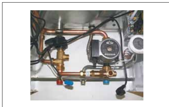
Obr. Demontovat přípojovací blok
