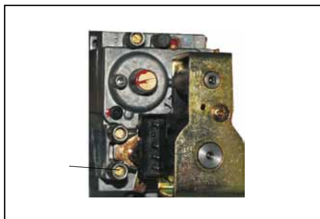
Obr. Přezkoušení připojovacího tlaku plynu
