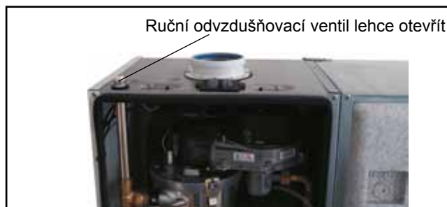
Obr. Ruční odvzdušňovací ventil
