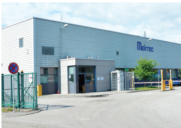
Mektec České Budějovice vzduchotechnické jednotky KG Top
