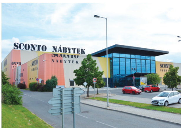
Sconto nábytek Černý Most, Praha vzduchotechnické jednotky KG Top, kompaktní jednotky C Klasse
