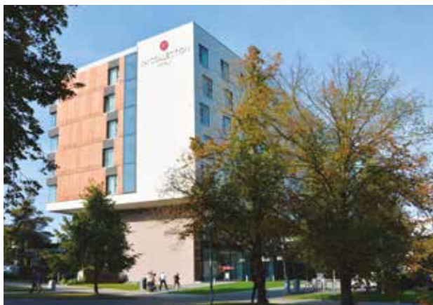
Hotel NH Collection Olomouc vzduchotechnické jednotky KG Top, kompaktní jednotka CFL
