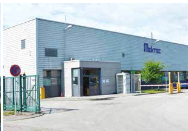
Mektex České Budějovice vzduchotechnické jednotky KG Top
