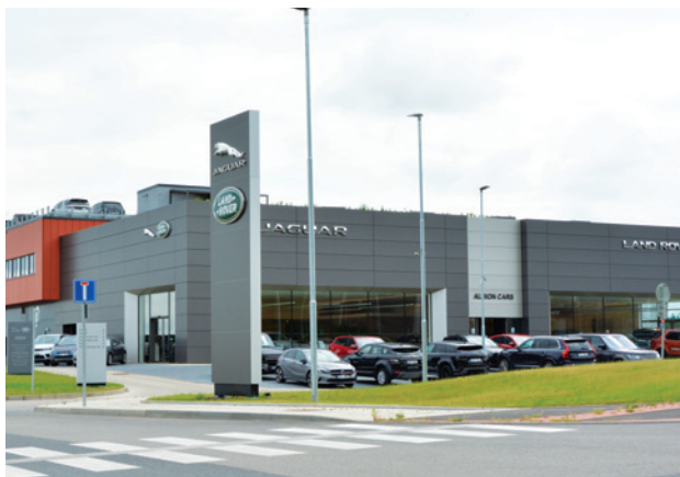
Autosalon Čestlice vzduchotechnické jednotky KG Top
