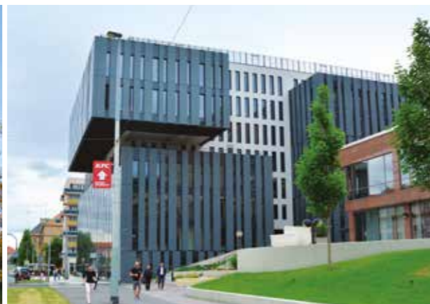
EGATE Evropská, Praha vzduchotechnické jednotky KG Top
