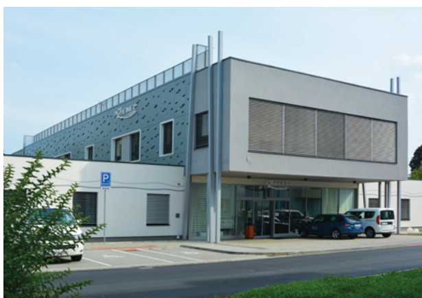
Alzheimer centrum Ostrava vzduchotechnické jednotky KG Top
