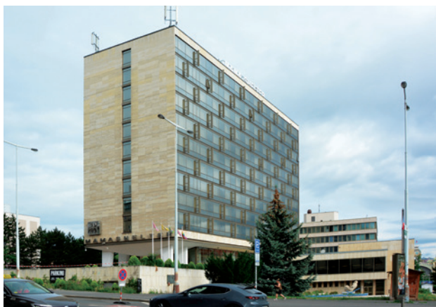
Hotel Mamashelter Praha vzduchotechnické jednotky KG Top
