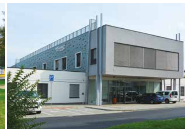
Alzheimer centrum Ostrava vzduchotechnické jednotky KG Top
