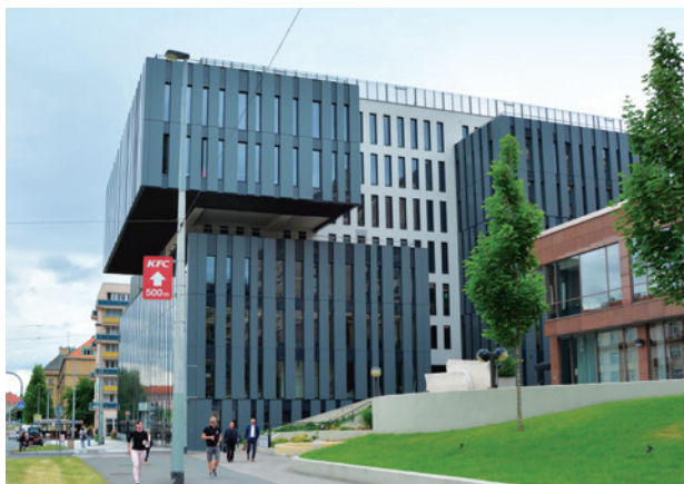
EGATE Evropská, Praha vzduchotechnické jednotky KG Top
