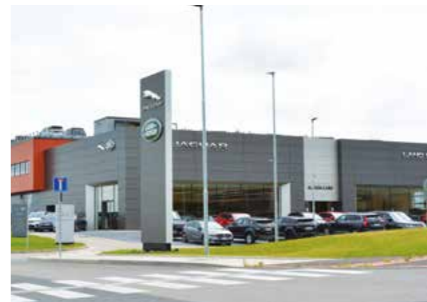
Autosalon Čestlice vzduchotechnické jednotky KG Top
