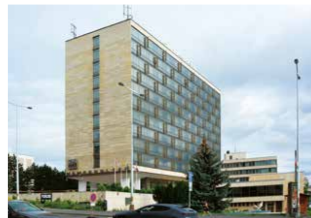
Hotel Mamashelter Praha vzduchotechnické jednotky KG Top
