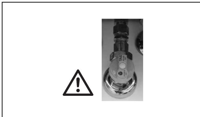
Prípojka plynu: Pozor, pri úniku plynu hrozí nebezpečenstvo otravy a výbuchu!
