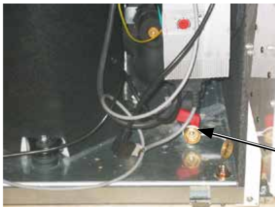
plnicí a vypouštěcí kohout okruhu solanky
