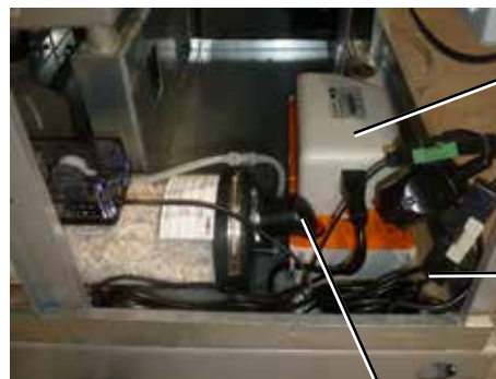
Σύνδεση αντλίας ανύψωσης συμπυκνώματος στην ουδετεροποίηση
