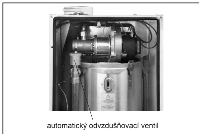
automatický odvodušňovací ventil
