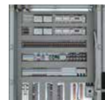
4 Kompletní systém MaR včetně regulátoru a ovládacího panelu, speciálně navržený pro bazénové jednotky
