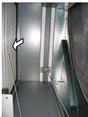
vyjměte filtr spojka jednotky
