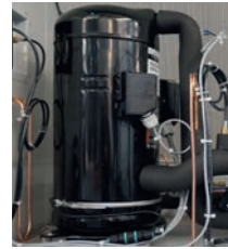
5. Bomba de calor de alta eficiencia, opcionalmente con regulación por inver- sor para conmutar entre modo de calefacción y de refrigeración
