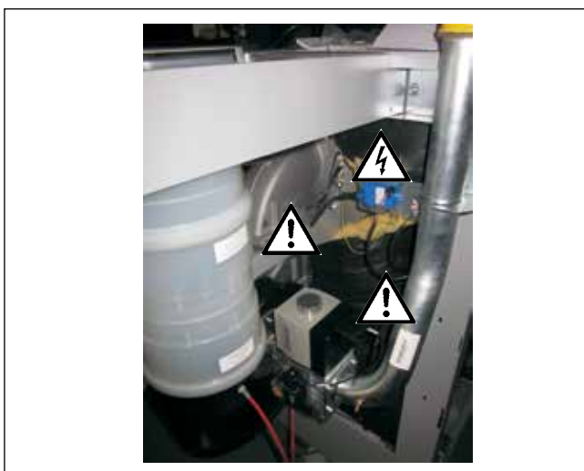
zapaľovací transformátor, vysokonapäťová zapaľovacia elektróda, kombinovaný plynový ventil, manostat plynu, ventilátor, spaľovacia komora
