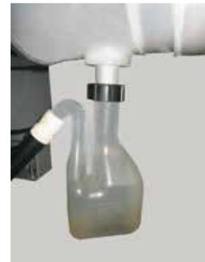
Unir con una pieza en T las mangueras de condensados de ambos sifones y conectarlas al desagüe/neutralizador de condensados.
