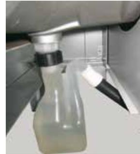
Montar el segundo sifón (exterior) en el racor del tubo adaptador para salida de gases de combustión con recogida de condensados
